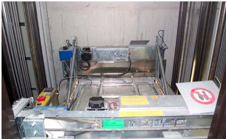
Machine Gearless à câbles, en haut de gaine, dans la trajectoire de la cabine
